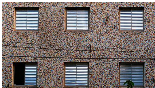
Figura 2 - Fotografia capturada da fachada do prédio – Jardim São Paulo - SP
